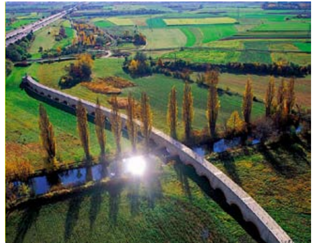
Kunstabauten wie das Aquädukt Leobersdorf ermöglichen den Fluss des Wassers nach Wien im freien Gefälle (Quelle: Wiener Wasserwerke)
