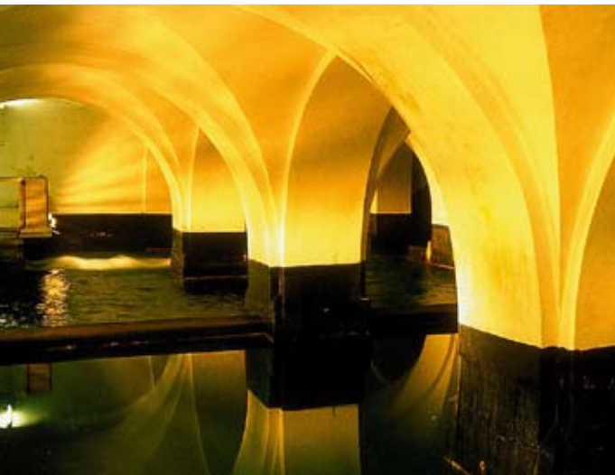
Im Inneren des Wasserbehälters Rosenhügel (Quelle: Wiener Wasserwerke)
